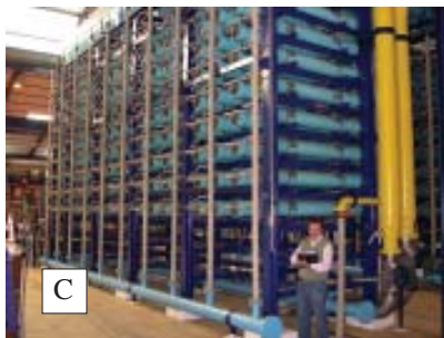
Figura 14. Proceso de desalación seguido en la planta de Marbella (parada 3), (esquema cedido por ACOSOL, S.A.). (A) Sala de bombeo de agua de mar. (4 bombas con capacidad para impulsar 500 l/s cada una). (B) Filtros de arena. (C) Bastidores de membranas y (D) Tanque de agua desalada, lista para su envío a la ETAP
